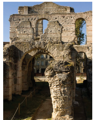
Vestiges du palais Gallien de Bordeaux.
